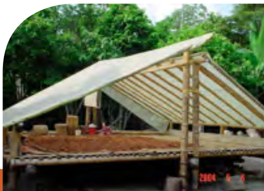
Un modelo de secadoras tipo marquesinas construídas de madera y plástico.
