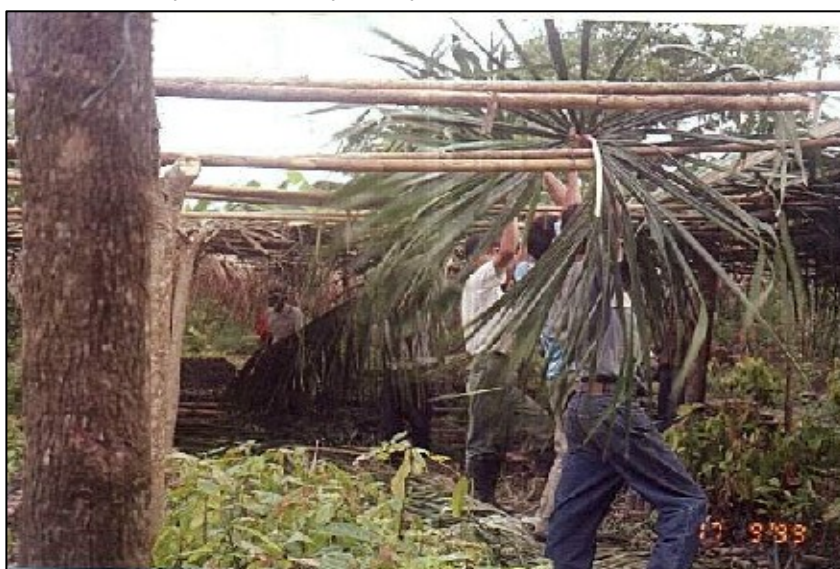
CONSTRUCCION DE TINGLADO
